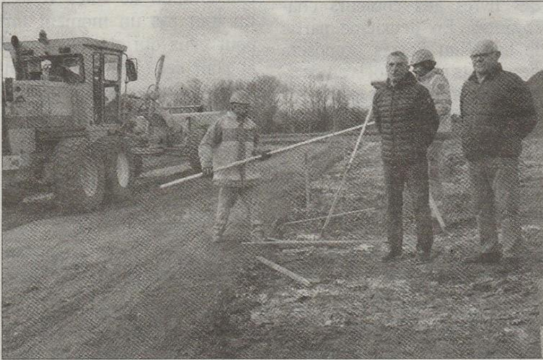
Terrassement sur le site Folch.
